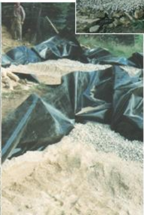
Bau einer PKA-Kaskade in Annaberg-Buchholz OT Tannenbergl, 1998
